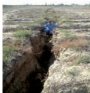
ایجاد ترک و شکاف
