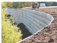
پایدارسازی شیب به روش دیوار حائل
