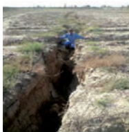
ایجاد ترک و شکاف
